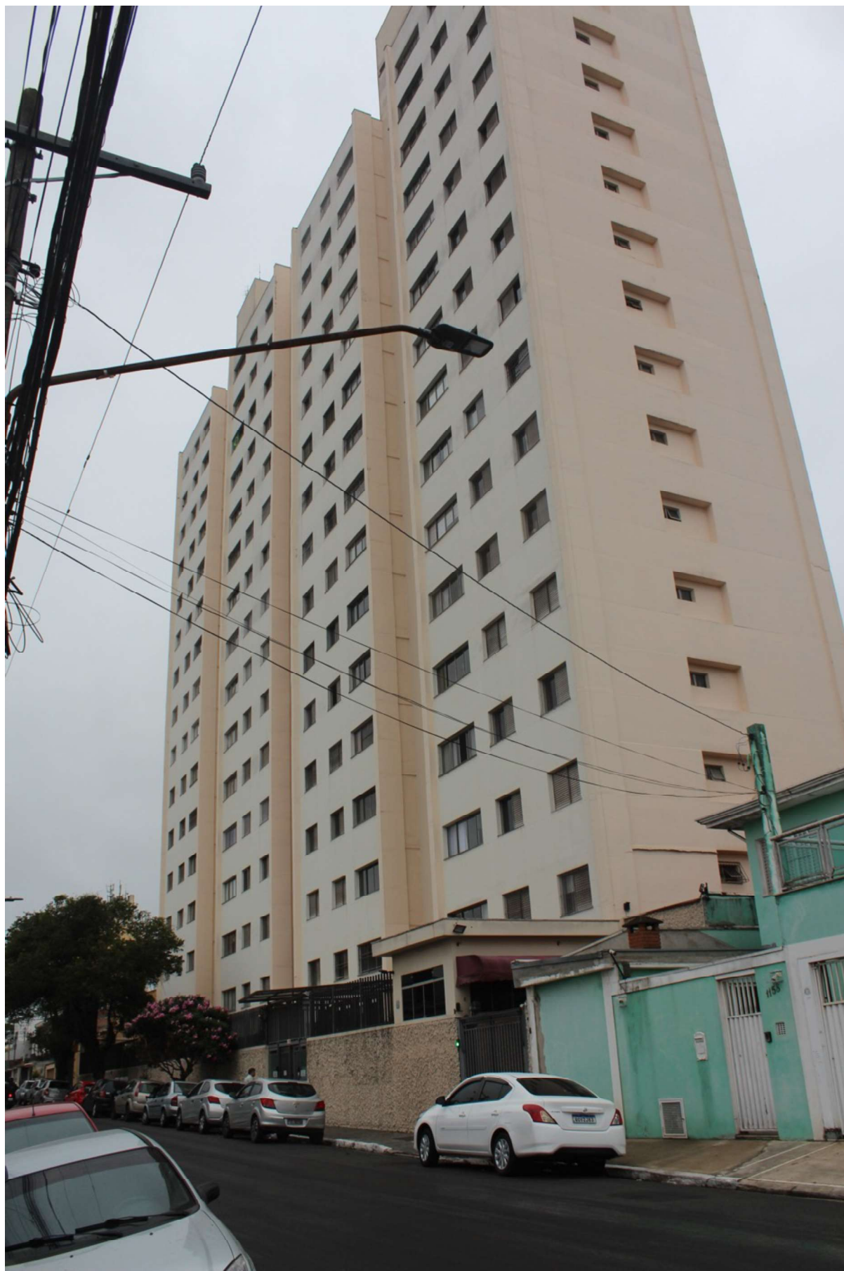
Legenda: Fachada Externa do Edifício Coemil VII.
