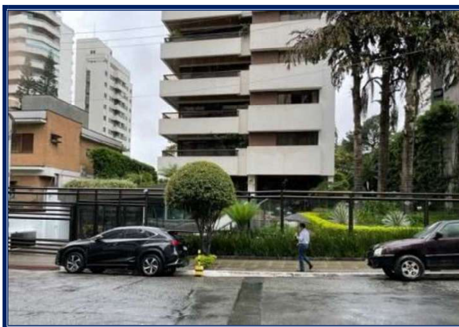
Vista da frente do Edifício Casa Blanca.
