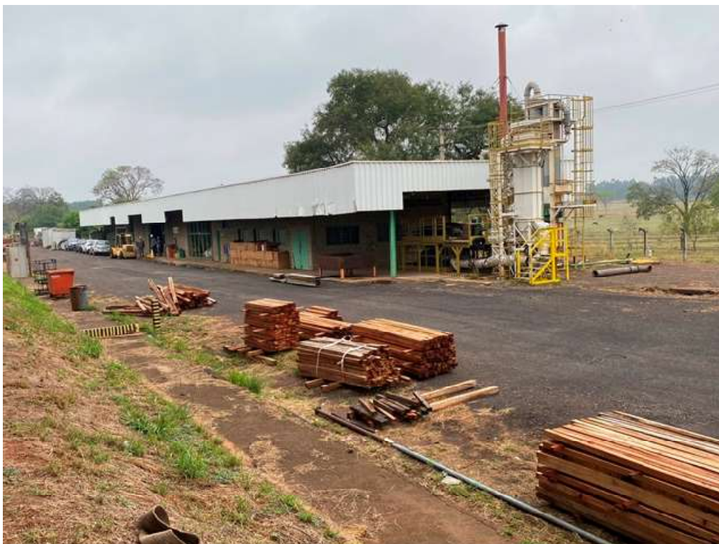
FOTO 14 – Vista da reciclagem.
