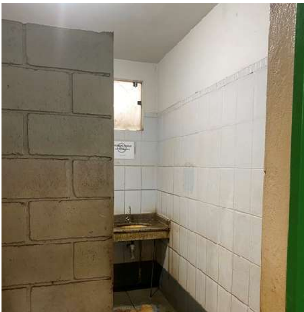
FOTO 12 – Sanitário localizado dentro do edifício industrial (denominado por Nave).
