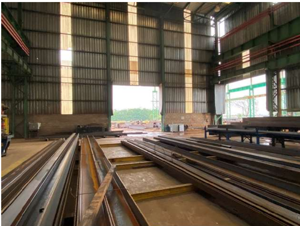
FOTO 09 – Vista interna do edifício industrial (denominado por Nave).
