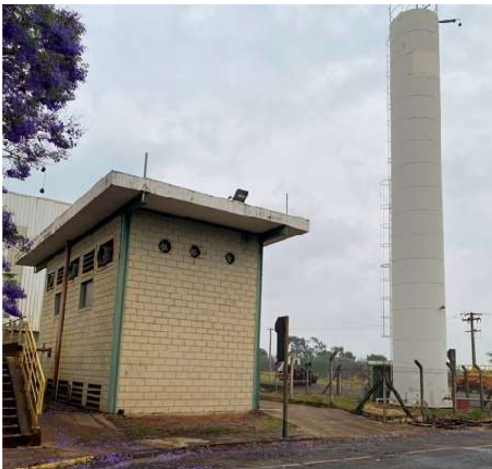
FOTO 06 – Vista da cabine de energia e compressores e caixa d'água metálica.
