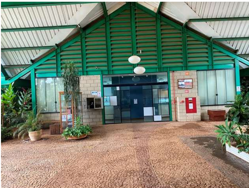
FOTO 03 – Prédio da administração.
