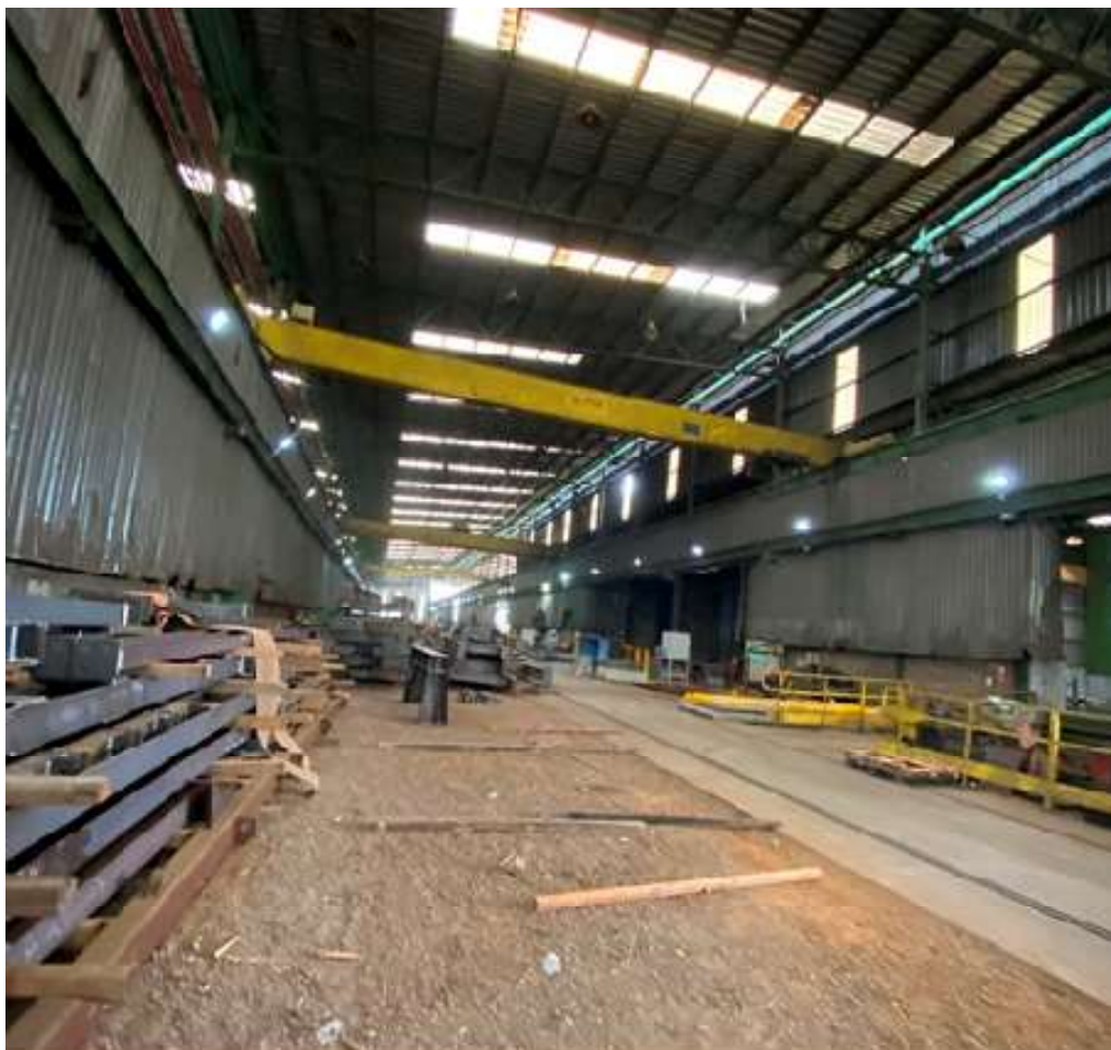
FOTO 10 – Vista interna do edifício industrial (denominado por Nave).
