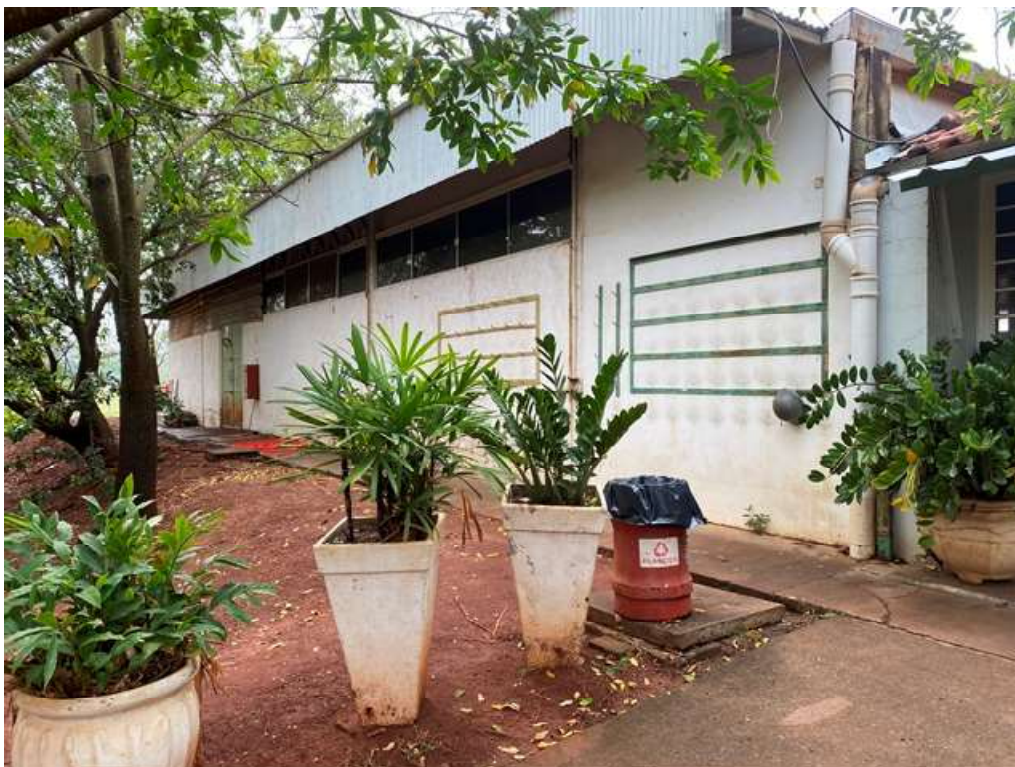
FOTO 17 – Vista do arquivo morto 2.
