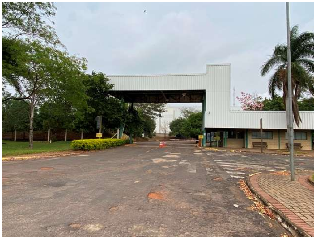
FOTO 19 – Vista da portaria.
