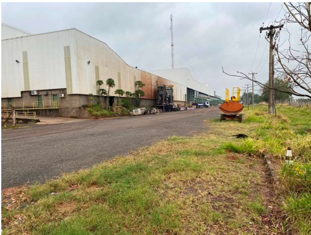
FOTO 07 – Vista da lateral externa do edifício industrial.
