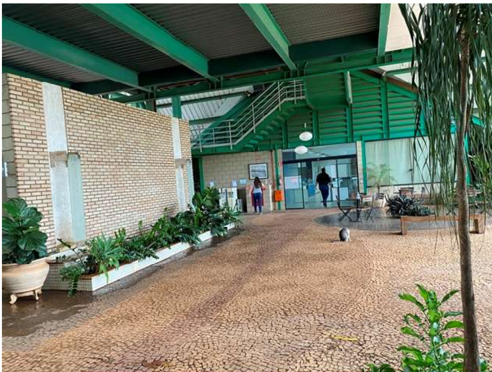
FOTO 04 – Prédio da administração por outro ângulo com escada para o pavimento superior.
