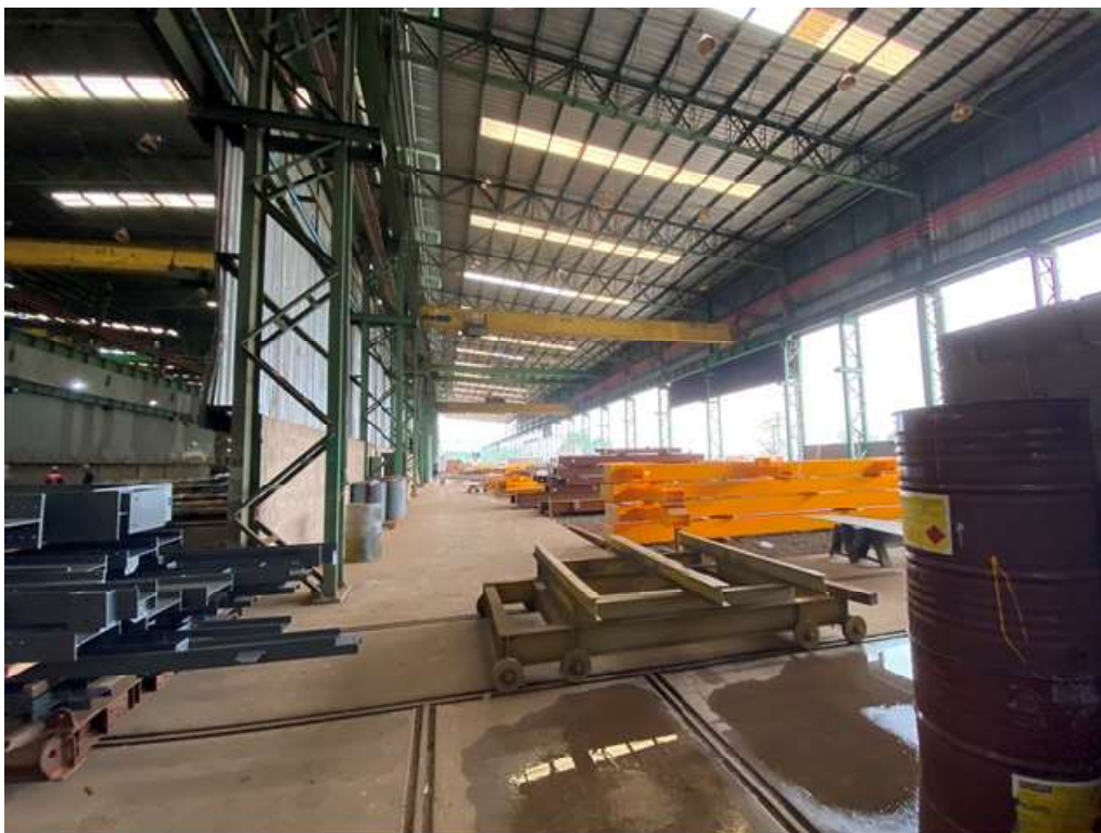
FOTO 08 – Vista interna do edifício industrial (denominado por Nave).
