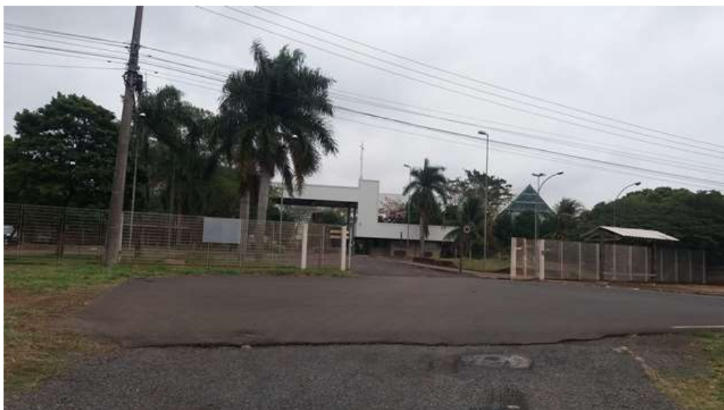
FOTO 01 – Imóvel localizado na Rodovia Euclides da Cunha – SP 320, km 455, cidade de Mirassol.
