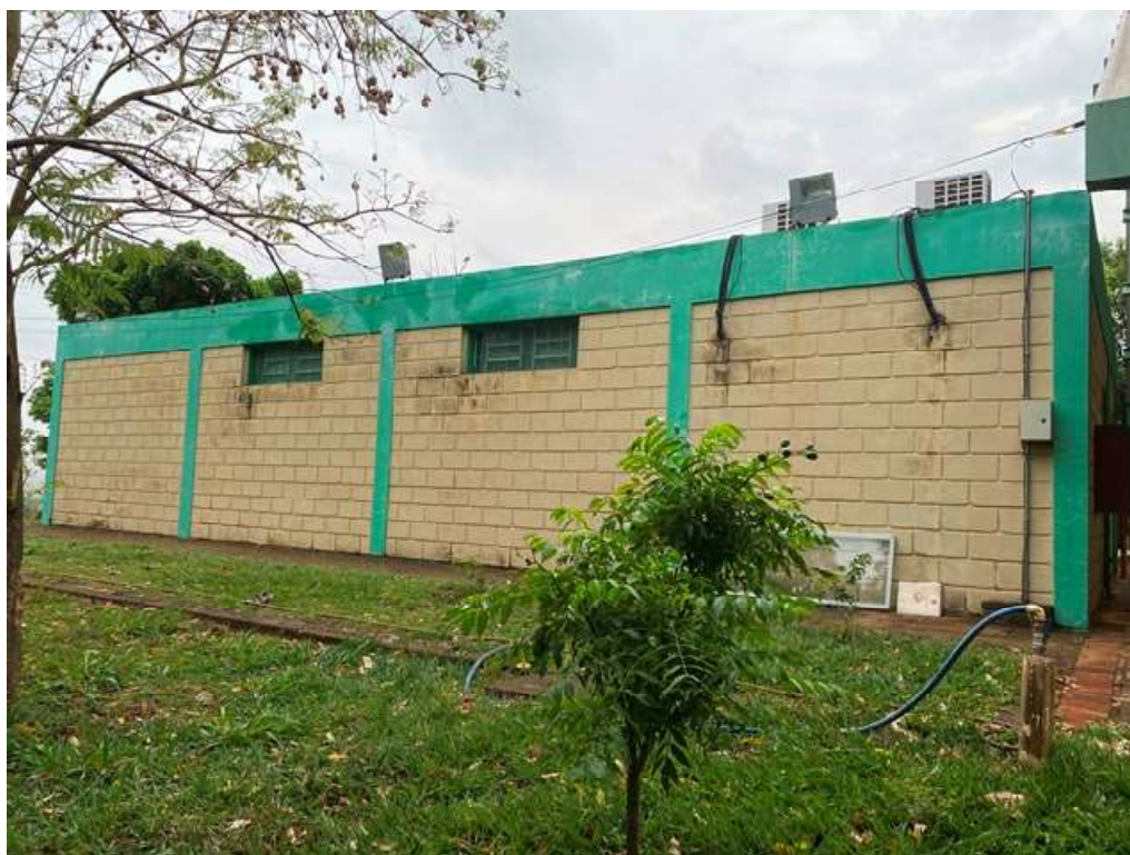
FOTO 05 – Vista do arquivo morto 1.
