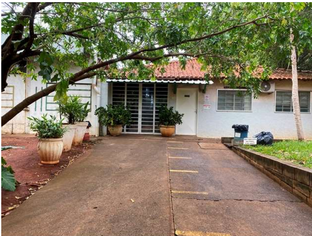
FOTO 15 – Vista do prédio que contém o refeitório (centro), arquivo morto 2 (a esquerda) e ambulatório (a direita).
