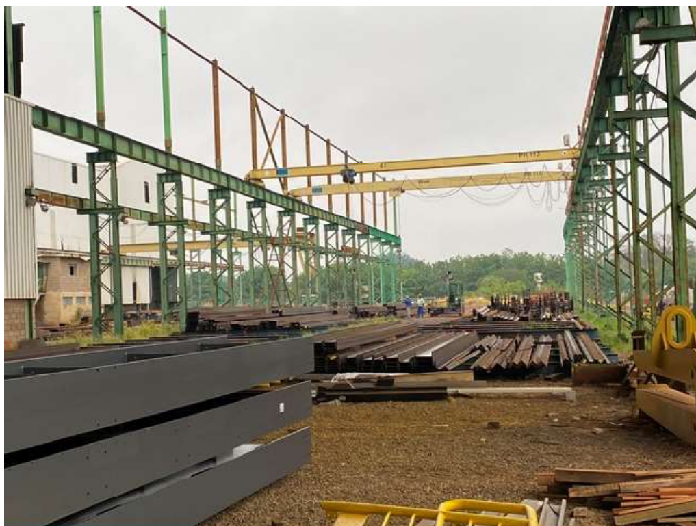
FOTO 13 – Vista do semipórtico.
