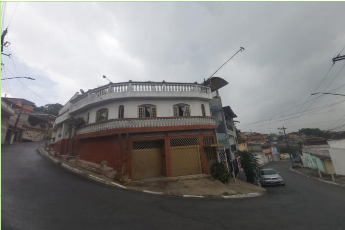
Foto da Fachada do Imóvel
