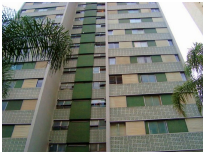
Vista parcial fachada Edifício Itassugui
