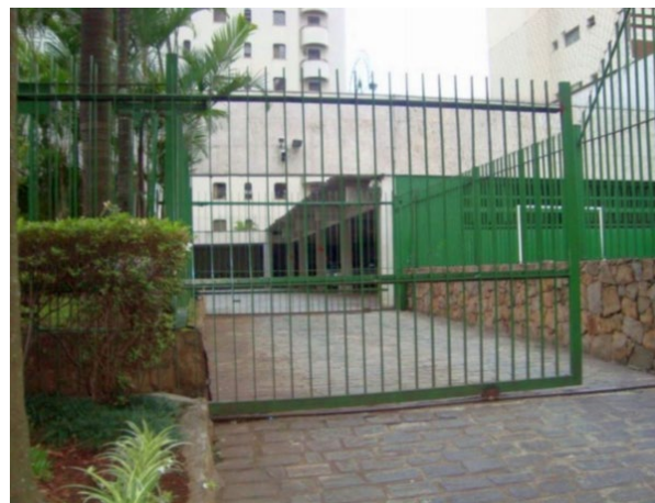
Vista parcial portão garagem térrea
