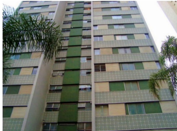
Vista parcial fachada Edifício Itassugui
