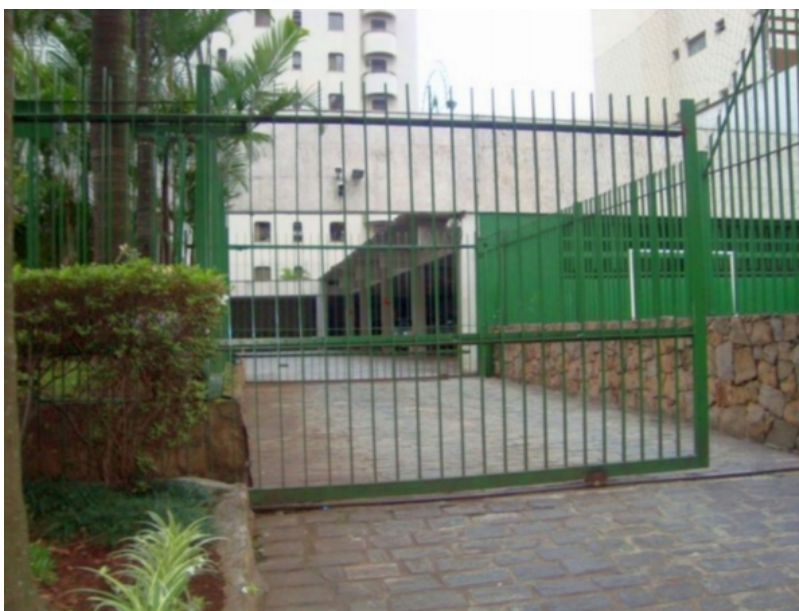
Vista parcial portão garagem térrea
