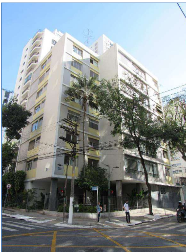
FACHADA DO EDIFÍCIO ZULMIRA.
