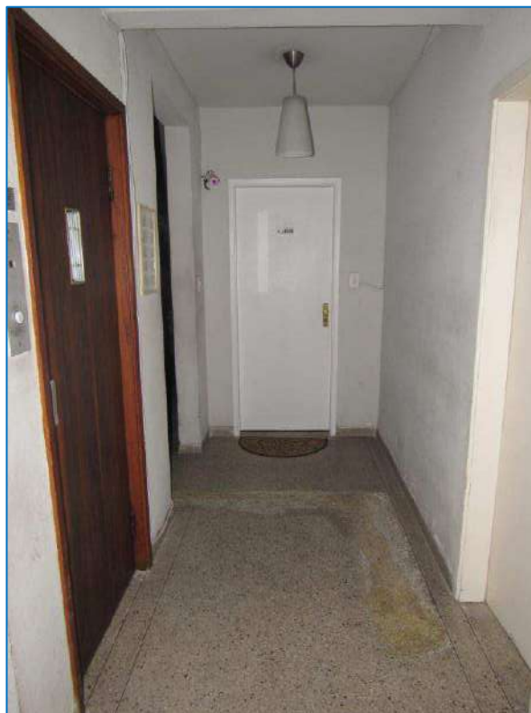
HALL DOS ELEVADORES.
