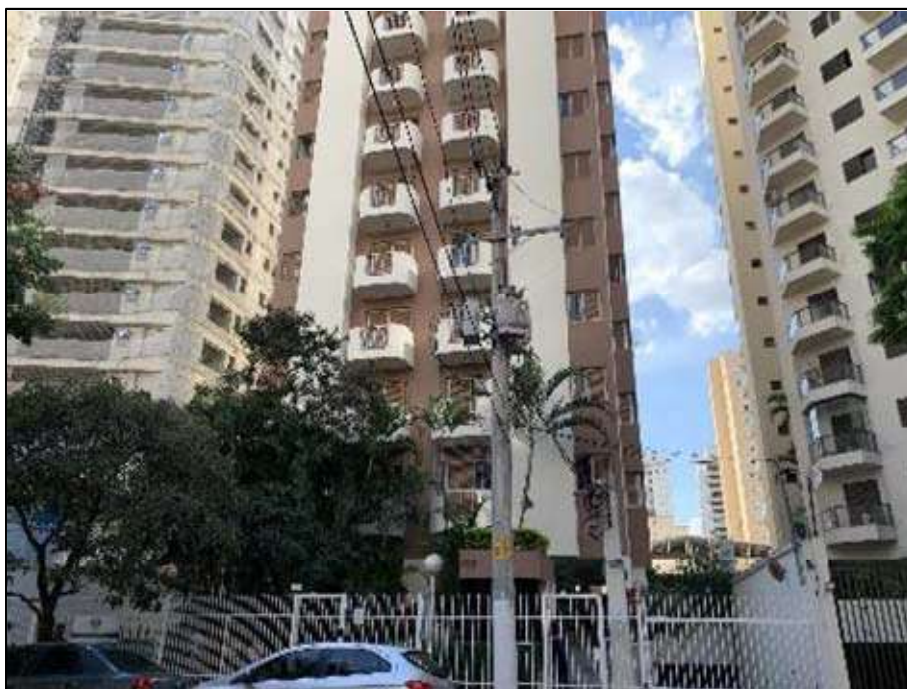
Foto 01. Fachada do imóvel avaliando.
