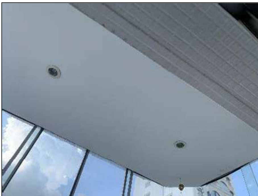
Foto 23. Detalhe do teto da varanda.
