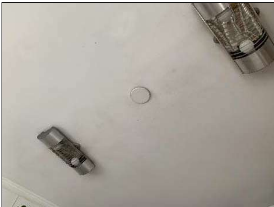
Foto 07. Detalhe do teto da cozinha.
