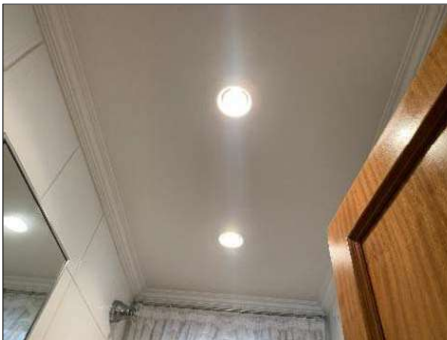
Foto 15. Detalhe do teto do lavabo.
